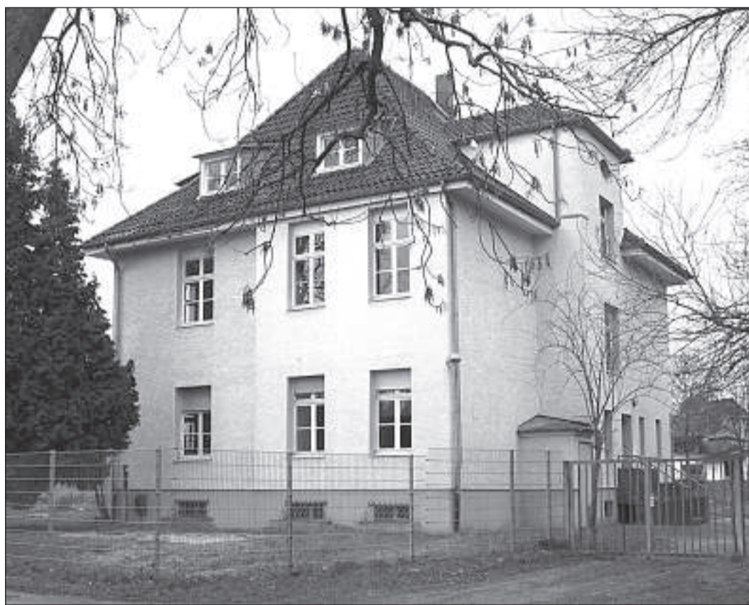
■ Die Villa konnte als Freizeitzentrum mit Angeboten für Kinder und Jugendliche erhalten bleiben. (Foto: Piepenbring)
